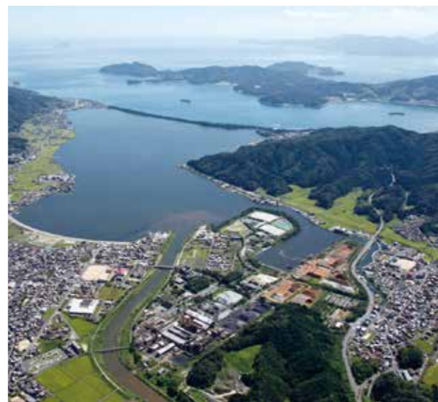
⇨ 空から見た工場の様子
