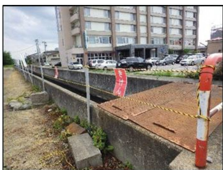
応急ロープの設置
