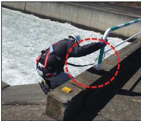
安全帯を使用し水路への転落を防止
