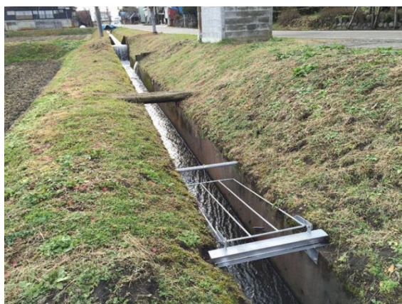
救助用スクリーンの設置
