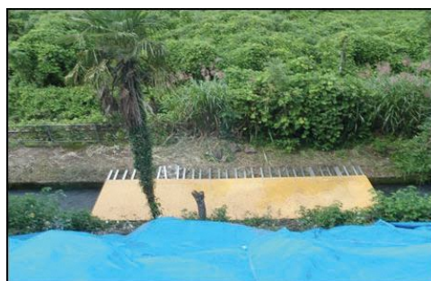
水路への仮蓋の設置
