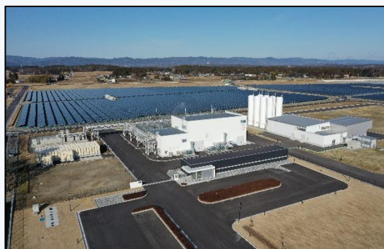
図 17 福島水素エネルギー研究フィールド
