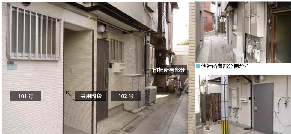
1階概観、共用階段入口付近
