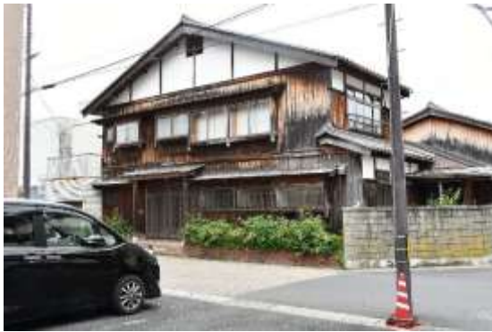
西堀川通り側
