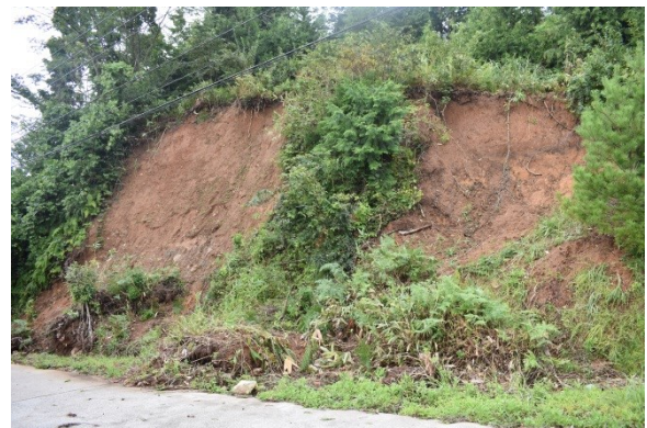
図145 成相寺旧境内の崩落被害(平成30年)
