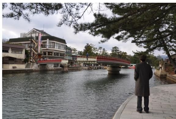
図91 橋梁・小天橋（回旋橋）
