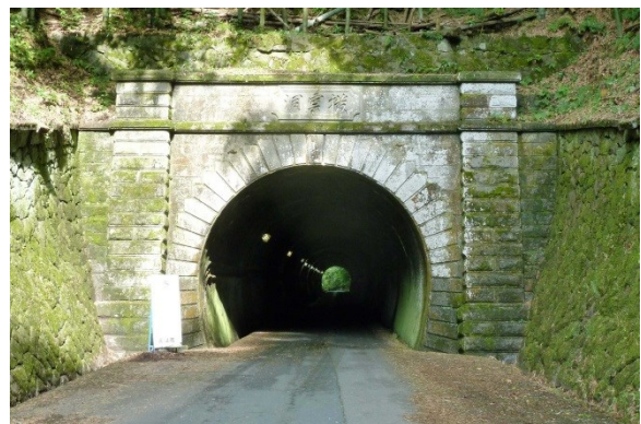
図 30 京都・宮津間車道の撥雲洞トンネル
