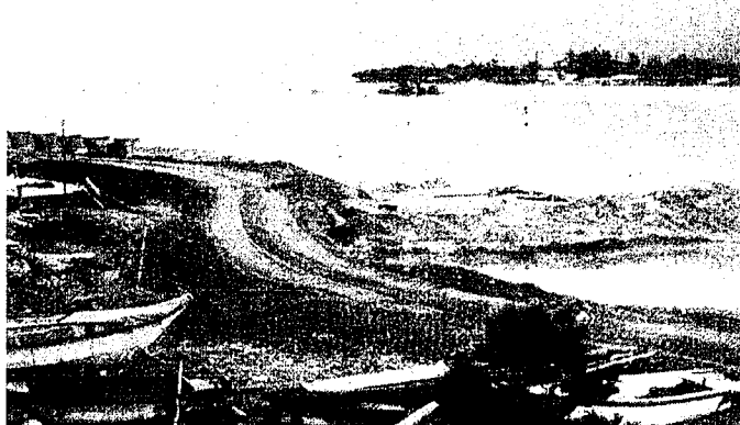
昭和48年高潮被害による護岸工事
