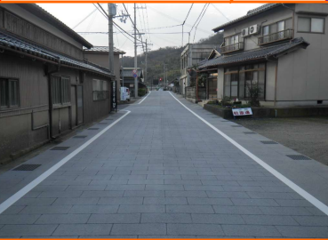
市道大垣難波野線修景工事 石畳風に改良
