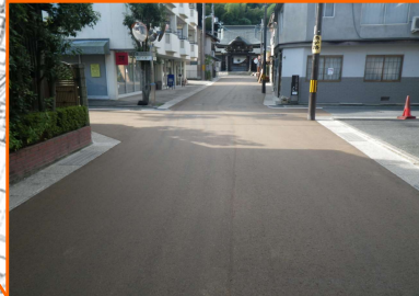
市道金屋谷線修景工事 道路部・路肩・側溝の改良
