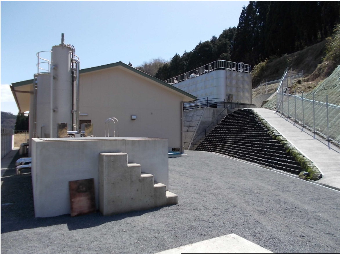
養老・日ヶ谷浄水場 平成 30 年 3 月竣工
