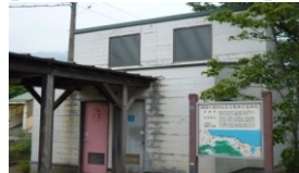
【丹後由良駅トイレ外観】
