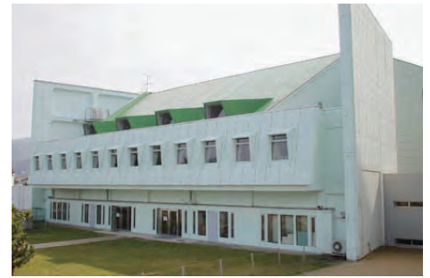
宮津会館（築52年）。老朽化も著しく、耐震安全性の基準も満たしておらず、吊天井落下の危険もあります。
