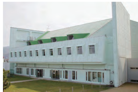
宮津会館（築 52 年）。老朽化も著しく、耐震安全性の基準も満たしておらず、吊天井落下の危険もあります。
