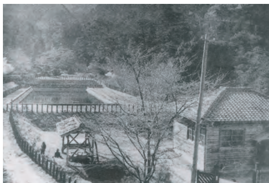
上水道の貯水池
