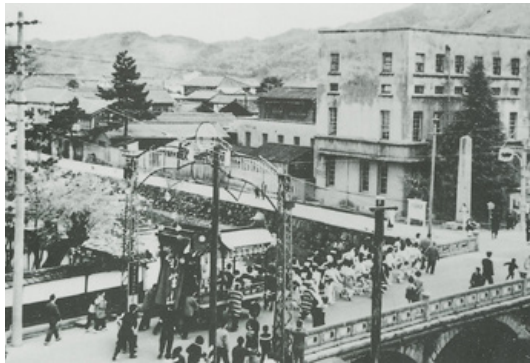
かつての大手橋（奥に「改造大手橋碑」が建つ）
