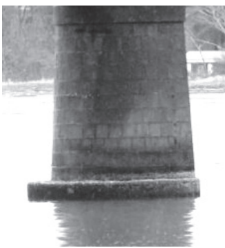
橋脚のずれ(KYOTO SIDEより)
