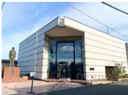
前尾記念クロスワークセンターMIYAZU(外観)
