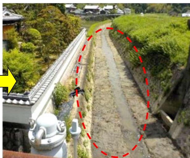
土砂を撤去して河川の流れを確保！
