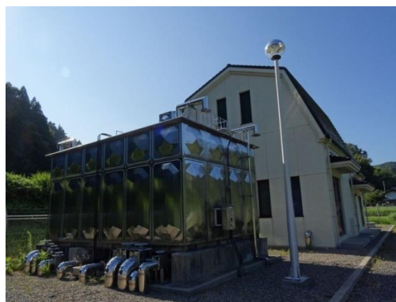
写真 3-2 波見谷浄水場（耐震性有）
