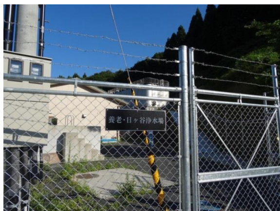
写真 3-1 養老・日ヶ谷浄水場（耐震性有）
