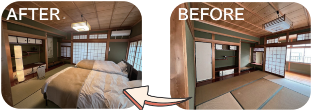
▲空き家活用モデル事業物件改修の様子
