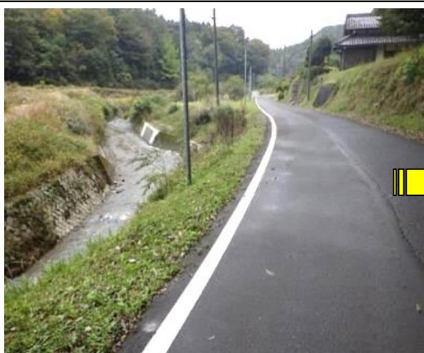
車両などが川に転落しそうで危険
