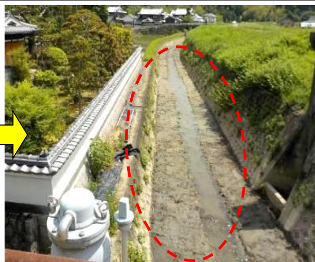
土砂を撤去して河川の流れを確保！
