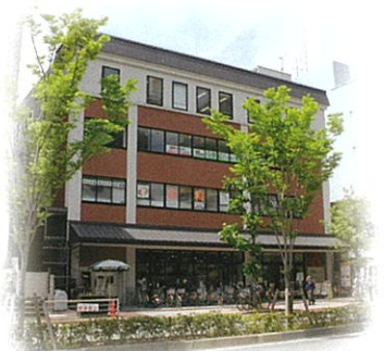
コープ御所南ビル
