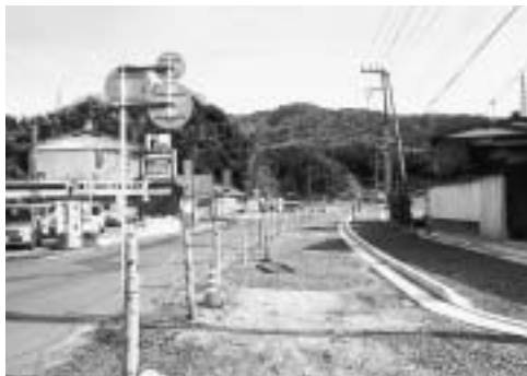
道路整備の様子
