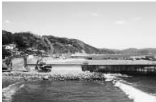
工事が進む里波見漁港
