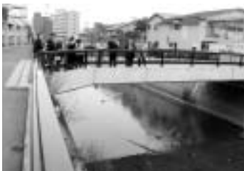
改修された区域
