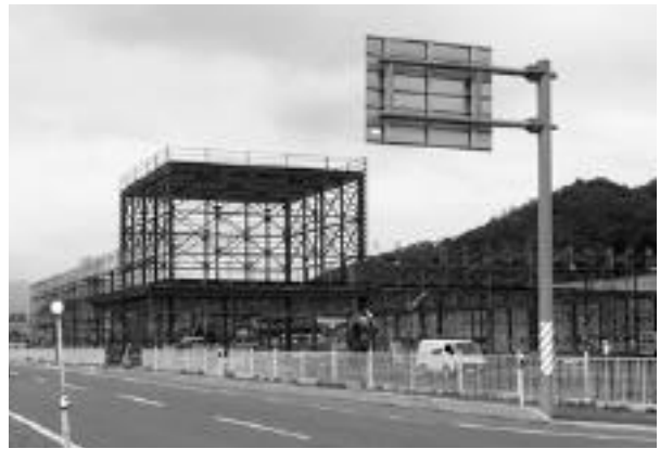
出店工事が進むケースデンキ野田川パワフル館
