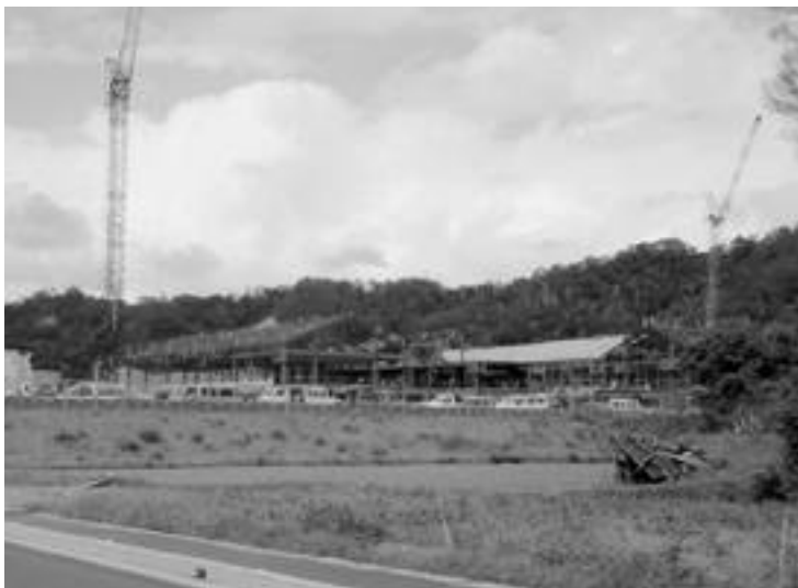
建設工事が進む特別養護老人ホーム（仮称）第二天橋園
