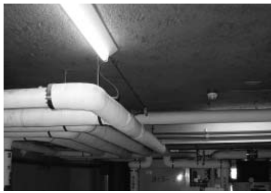
庁舎別館5Fボイラー室天井の吹き付けアスベストの様子
