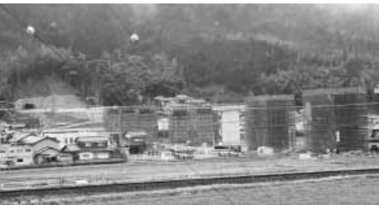
橋脚工事が進む鳥取豊岡宮津自動車道（宮津野田川道路）
