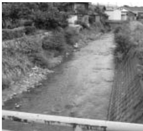
改修予定の生野橋・中嶋橋
