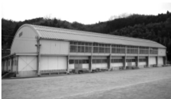
宮津中学校屋内運動場
