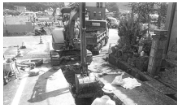
下水道管布設工事状況
