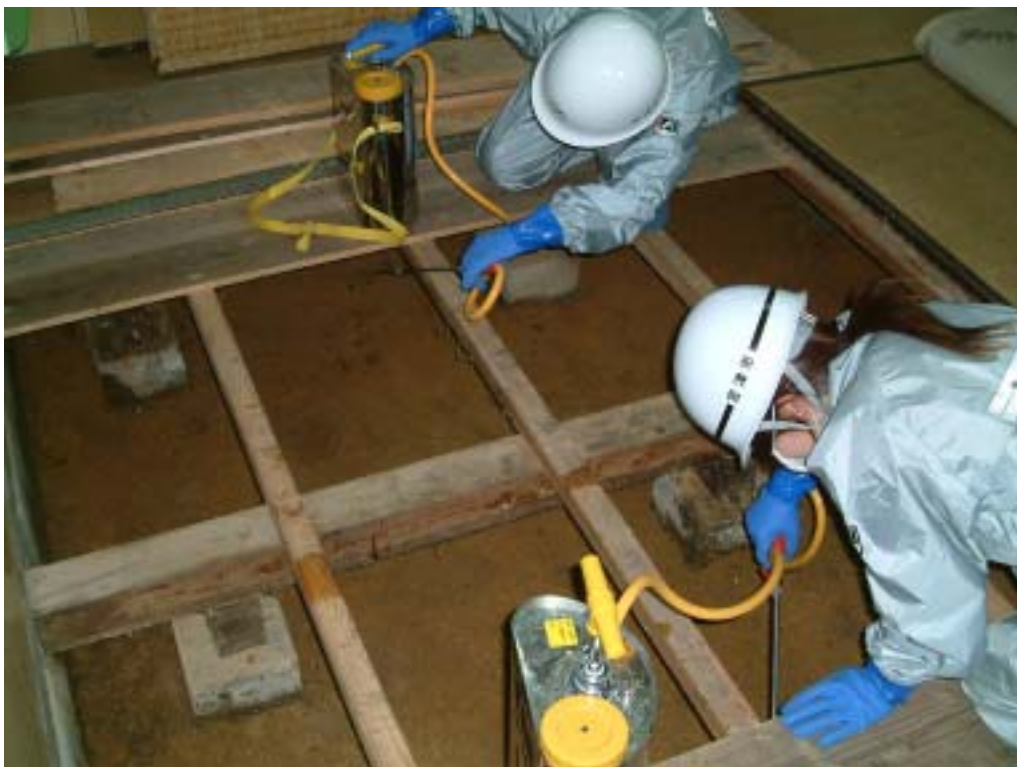
浸水家屋の消毒作業
