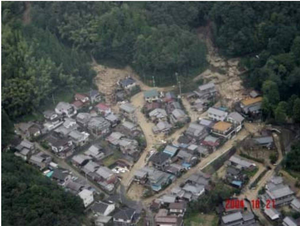
滝馬地区（金引団地）を襲った土石流
